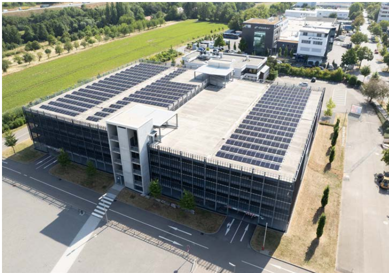
Installationsfortschritt unserer neuen PV-Anlagen in Heilbronn
